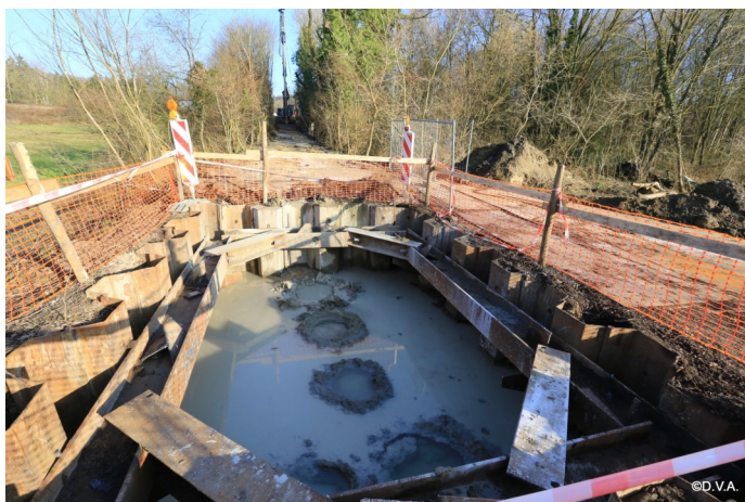
De parking in de Reigersstraat was een tijdje onbereikbaar door de werken aan de collector.
