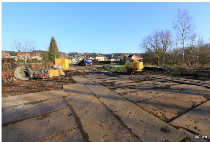
De aanleg van de collector heeft grote impact op het landschap en de rust in de Toemaat. Hopelijk verloopt alles zoals voorzien en worden de werken op zo kort mogelijke tijd afgerond.
