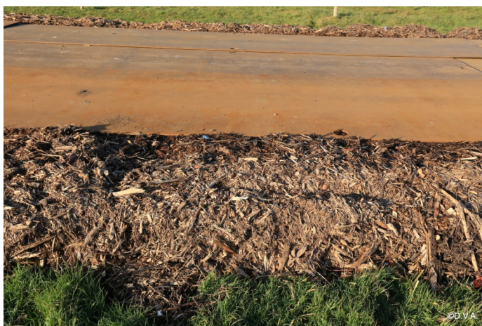
Een worteldoek, een dik pak houtsnippers en daarbovenop metalen rijplaten moeten verhinderen dat de bodem tijdens de collectorwerken beschadigd wordt door de zware machines. Na de werken neemt de aannemer alles terug weg.
