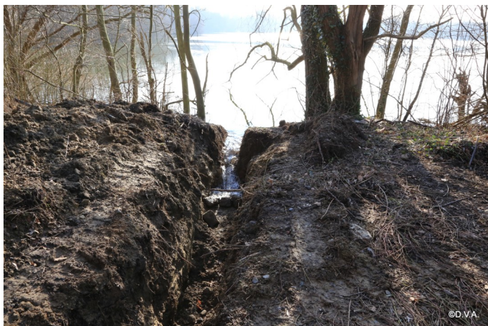
Door de verstopte monnik dreigde de Langerodevijver te overstromen. Een sleuf in de dijk biedt tijdelijk een oplossing.
