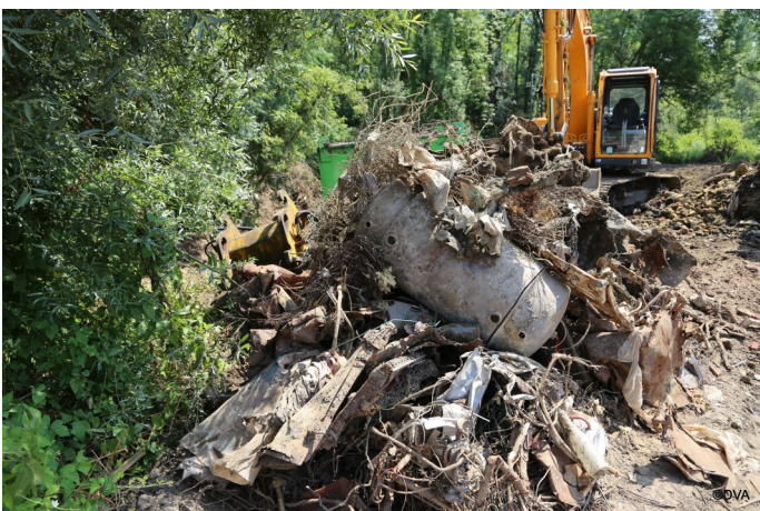
Het stort aan het Langerodebos werd volledig afgegraven en gezeefd. Het grove stortmateriaal is weggehaald. De resterende grond wordt momenteel onderzocht op mogelijke verontreiniging.
