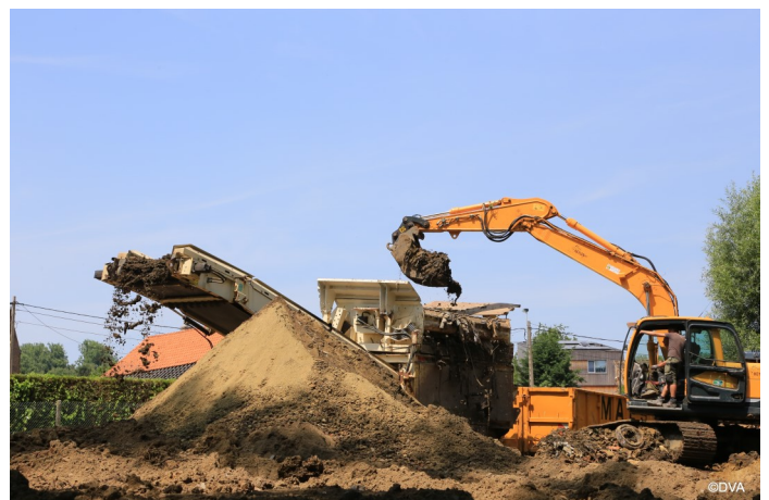
Zeven van de vervuilde grond aan het Langerodebos.
