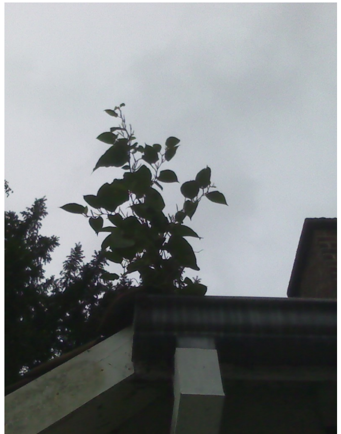
Japanse duizendknoop in dakgoot.
